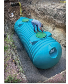
Enfouissement d'une citerne de récupération d'eau de pluie
